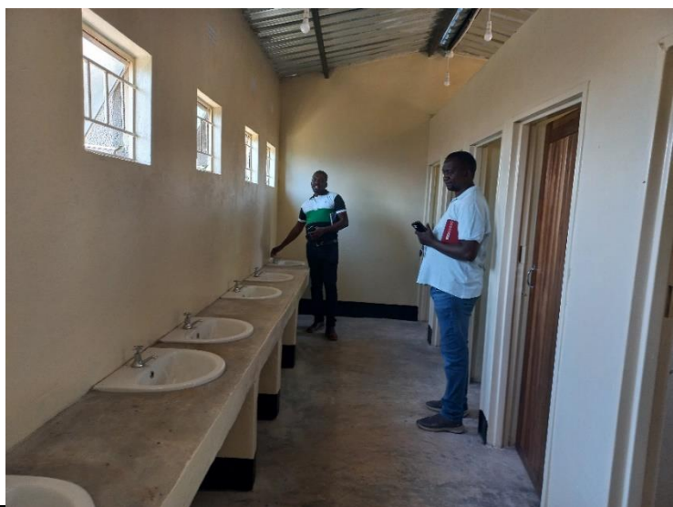
Eindinspectie toiletten Chainda Open Primary School door de gemeenteraad van Lusaka en de aannemer. (De binnenkant van het toiletgebouw).
