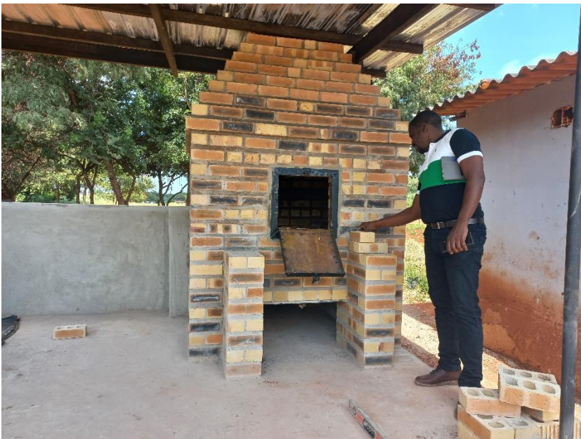
Afbeelding 1: Inspecteur ruimtelijke ordening van de stad Lusaka tijdens de eindinspectie van de verbrandingsovens op Chainda Open Primary School.
